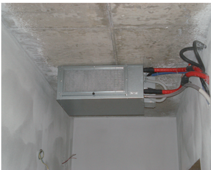
I deumidificatori sono situati nei controsoffitti di disimpegno, bagni e nelle cucine più grandi, collegati con brevi canalizzazioni flessibili ai singoli vani.
