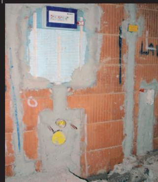
**GLI SCARICHI.** Un dettaglio relativo ai sistemi di scarico in Geberit PE.
