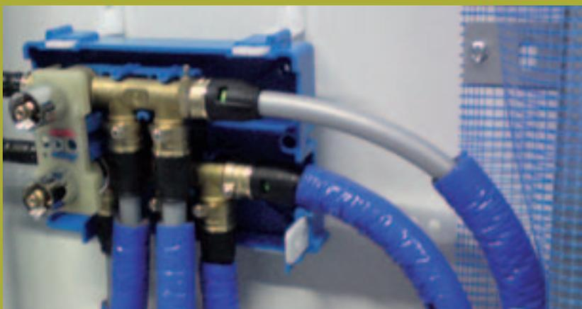
La velocità di esecuzione tipica dei sistemi ad innesto unita all'affidabilità e alla sicurezza tipiche di Geberit. Sono queste le certezze che può offrirvi il nuovo sistema PushFit, il primo sistema multistrato Geberit disponibile nei d 16, 20 e 25 mm che non prevede l'utilizzo di attrezzi. Il tubo multistrato flessibile e leggero ed i raccordi robusti e resistenti con indicatore di "innesto avvenuto", sono sinonimo di fiducia e sicurezza.
