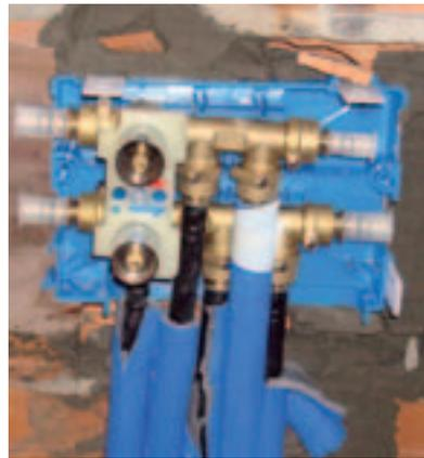
*La distribuzione di acqua e il riscaldamento sono affidati a Geberit Mepla, il sistema pressfitting multistrato metallo-plastico, dalle elevate caratteristiche fisiche e tecniche.*
